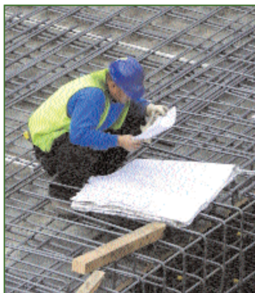
Рис. 1 Работа с чертежами на бумажной основе на строительной площадке
